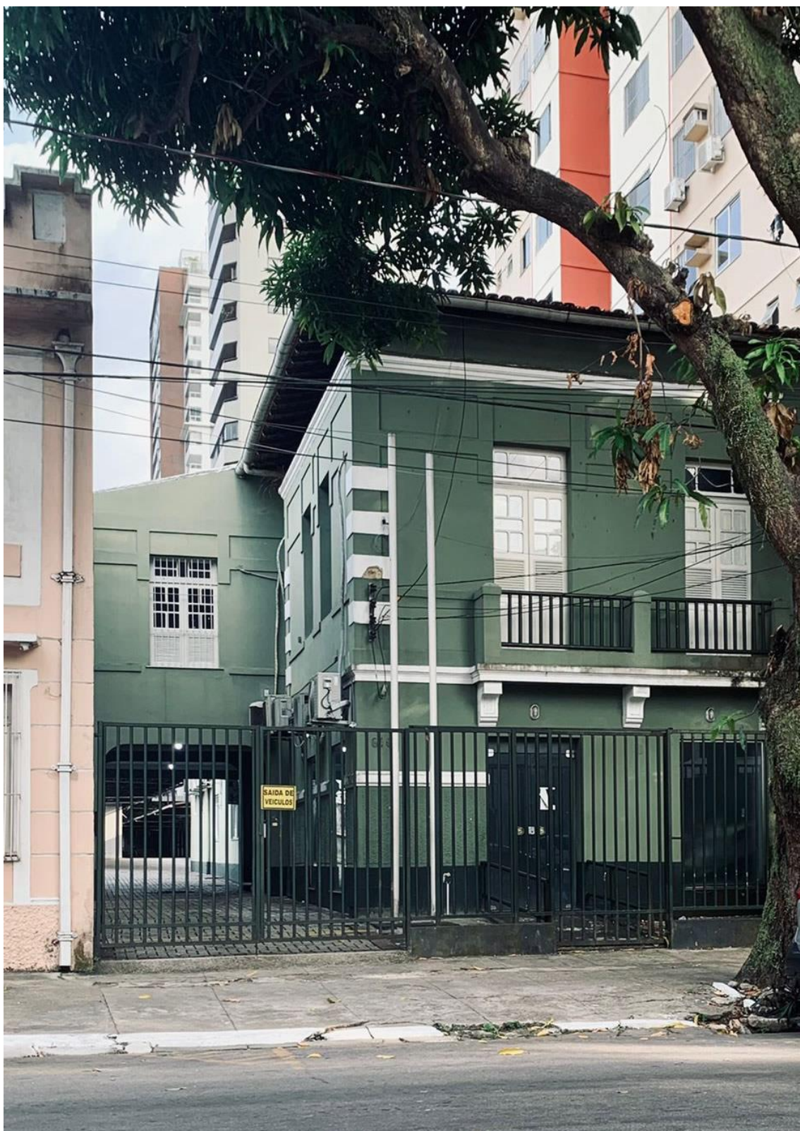
Foto recente (2021) da Casa da rua Conselheiro Furtato, 616.
