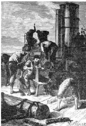
...um furor de demolição...
