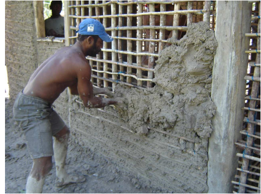
Foto 6: Morador rebocando a casa
